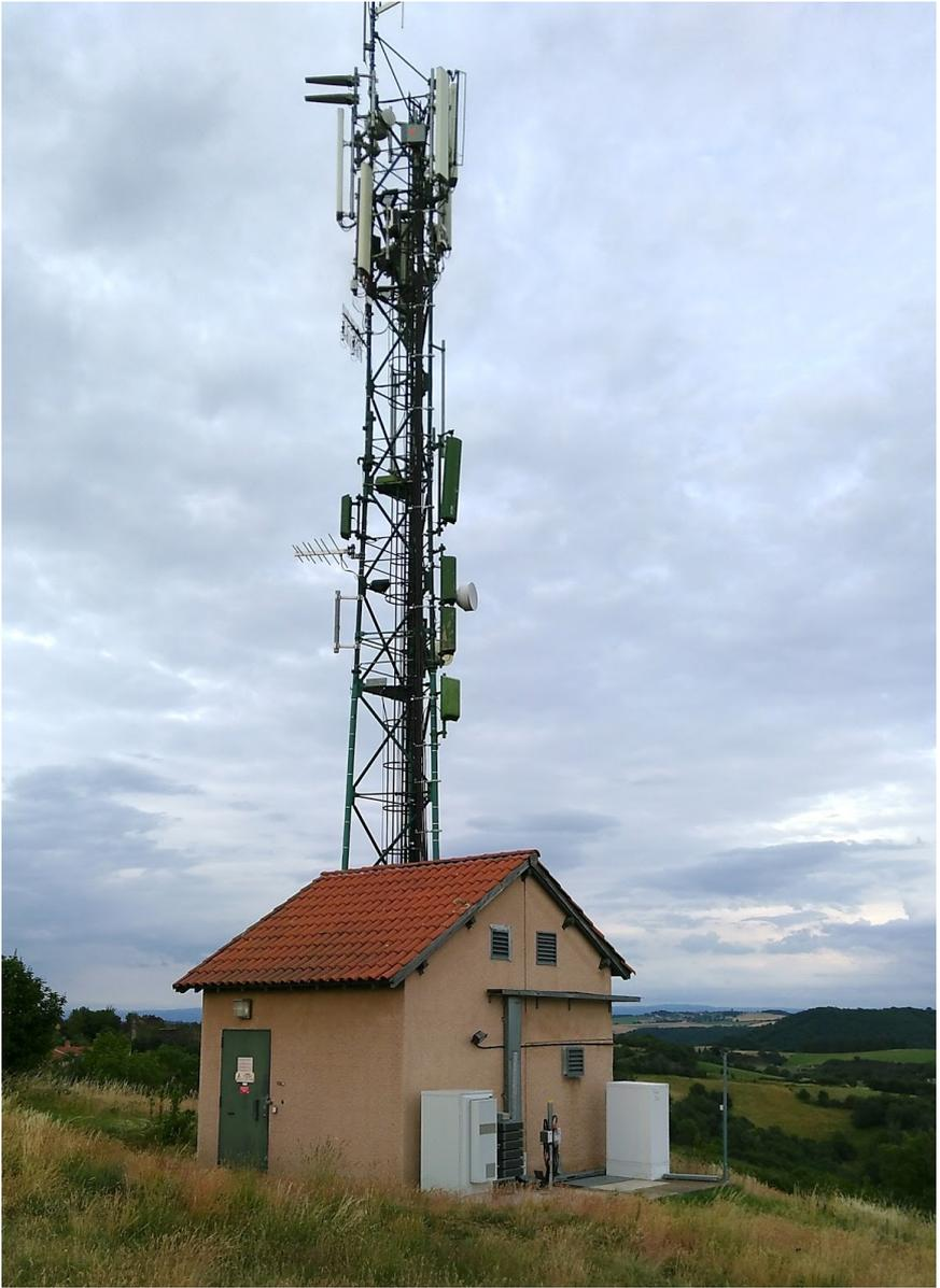
*Fig. 14 : Site de transmission dans le Cantal (support, stations, antennes 2G, 3G, 4G et faisceau hertzien)*
