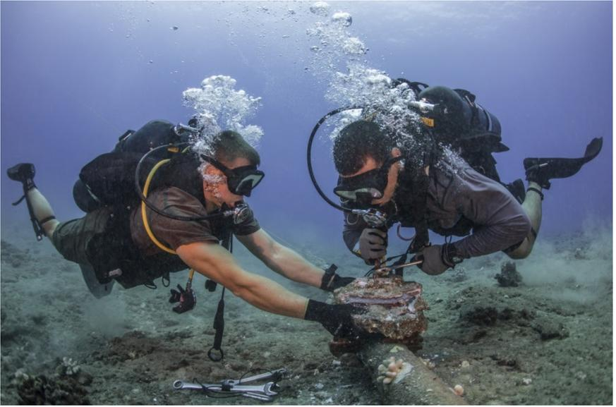
*Fig. 12 : Des plongeurs enlèvent des anodes de zinc corrodées sur un câble sous-marin près d'Hawaii*
